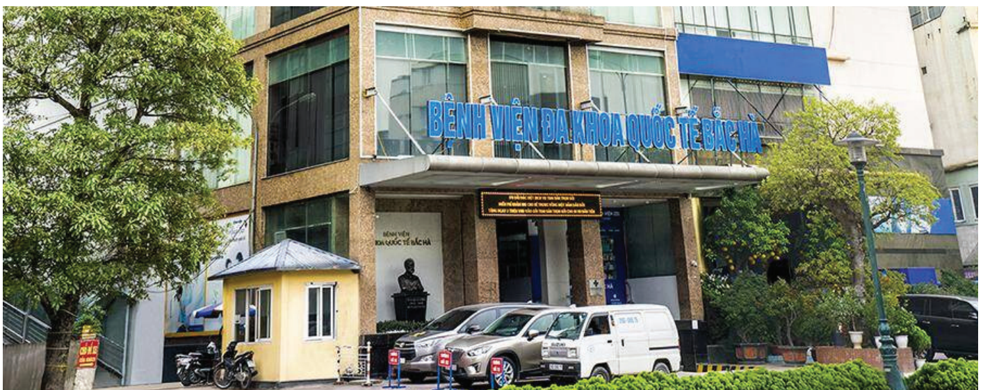
BỆNH VIỆN ĐA KHOA QUỐC TẾ BẮC HÀ - TƯ VẤN, THIẾT KẾ, THẨM DUYỆT, THI CÔNG PCCC Bac Ha International General Hospital – Consulting, Design, Approval, Fire Prevention Construction
