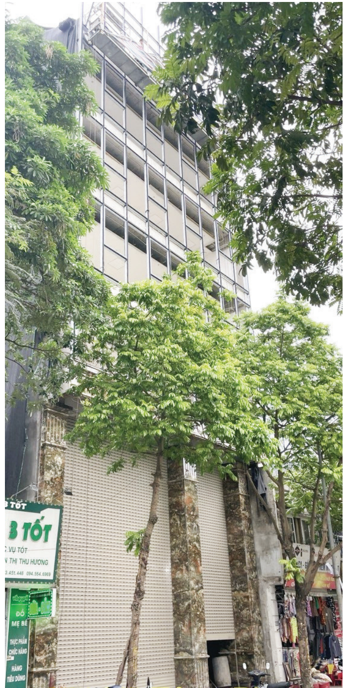
THI CÔNG LẮP ĐẶT HỆ THỐNG BÁO CHÁY Construction and installation of Fire Alarm system
