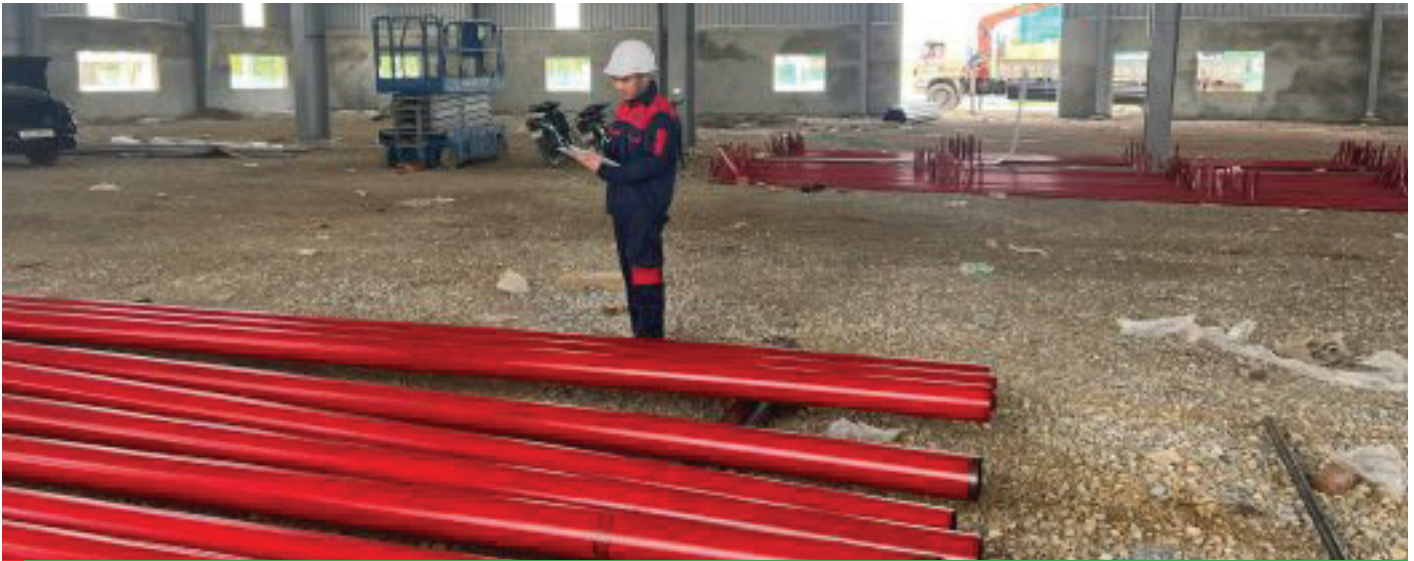
NHÀ MÁY SẢN XUẤT ỐNG NHỰA VÀ PHỤ KIỆN ADP HÀ NAM - THI CÔNG LẮP ĐẶT HỆ THỐNG PCCC ADP Ha Nam Plastic Pipe and Fittings Factory – Construction and Installation of Fire Protection Systems
